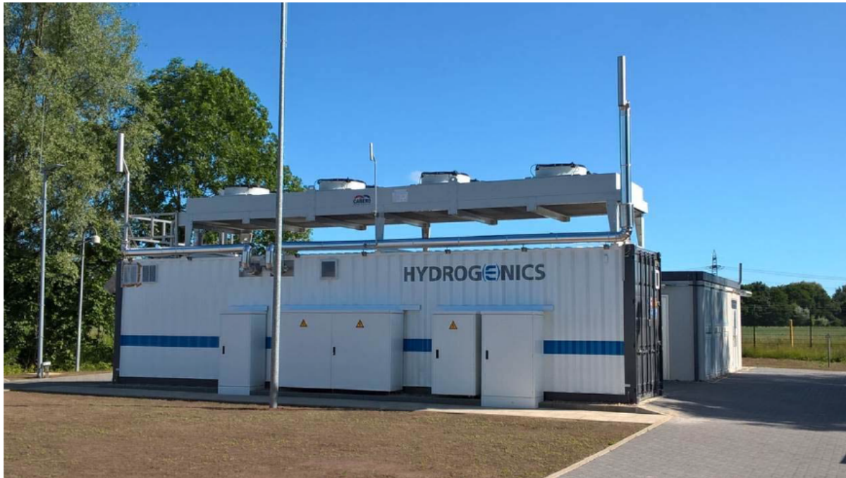
Abbildung 3-6: 1 MW-PEMEL-Anlage der Firma Hydrogenics am Standort Hamburg Reitbrook (Bayer, et al., 2016)
