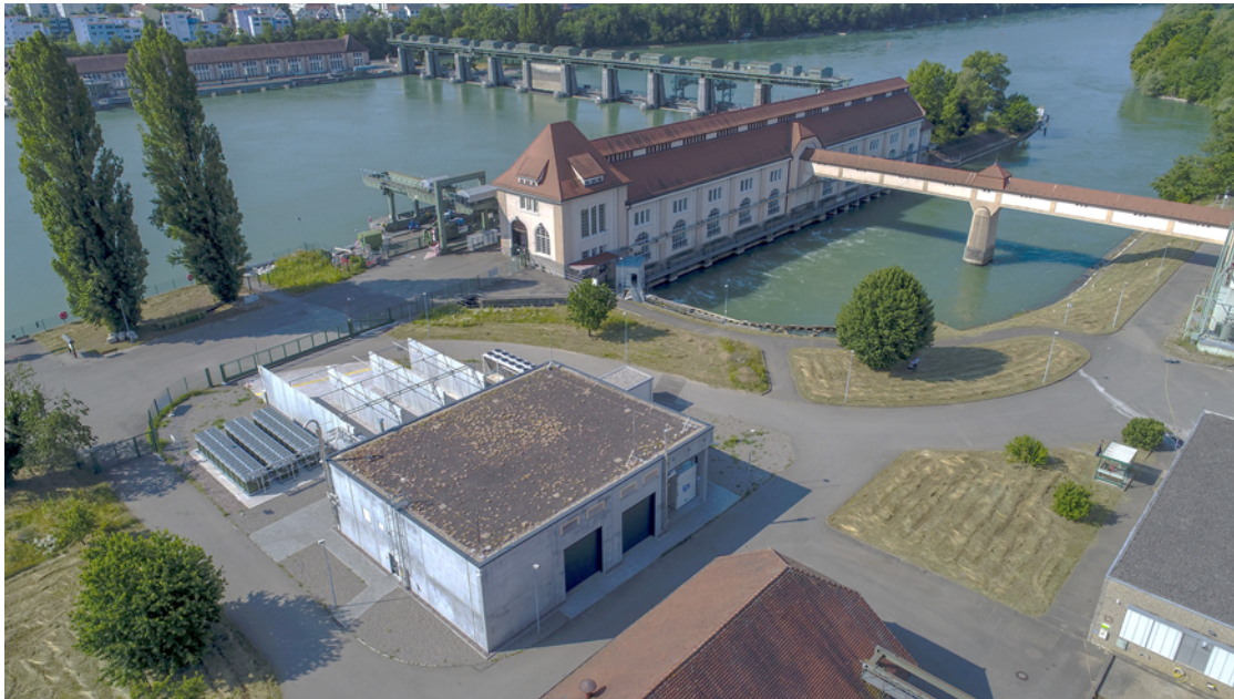
Abbildung 3-2: Foto der Power-to-Gas-Anlage in Grenzach Wyhlen auf dem Gelände des Wasserkraftwerks Wyhlen am Rhein
